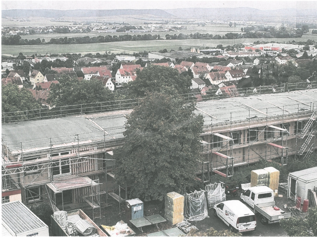
In eine Großbaustelle hat sich derzeit die Werner-von-Siemens-Realschule verwandelt. Auf dem Dach dieses Trakts wird die Friedrich-Wilhelm-Raiffeisen Energie eG eine Photovoltaik-Anlage errichten, außerdem auf zwei weiteren Gebäudeteilen und auf einem Bereich der Karl-Ludwig-von-Guttenberg-Grundschule.
