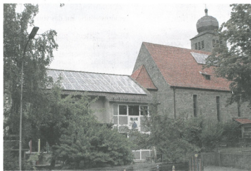
Ans Netz gegangen ist jetzt die Photovoltaik-Anlage auf dem Dach des evangelischen Kindergartens.
