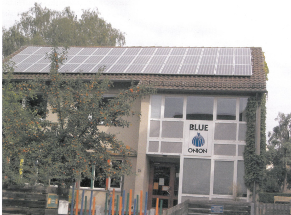
Photovoltaik-Anlage auf dem evangelischen Kindergarten Bad Neustadt
